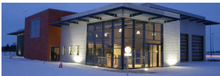
Volvo Trucks, centre de maintenance poids-lourds (capacité de 90 véhicules). Ouverture en Janvier 2012.
